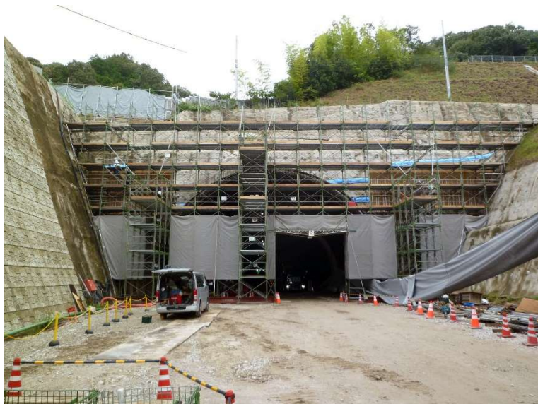
③ 高速 5 号線 NATM トンネル工事
