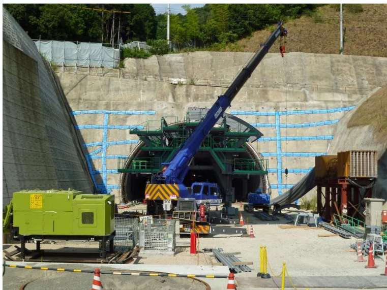
③ 高速 5 号線 NATM トンネル工事
