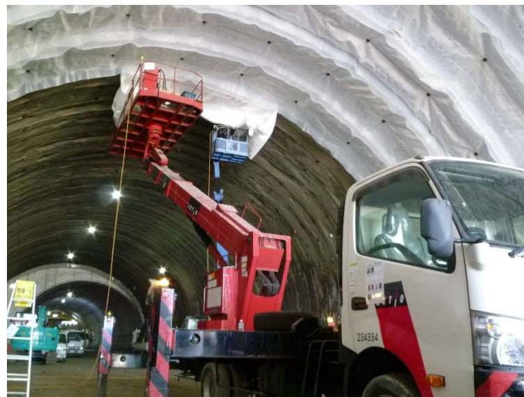
④ 高速 5 号線 NATM トンネル工事
