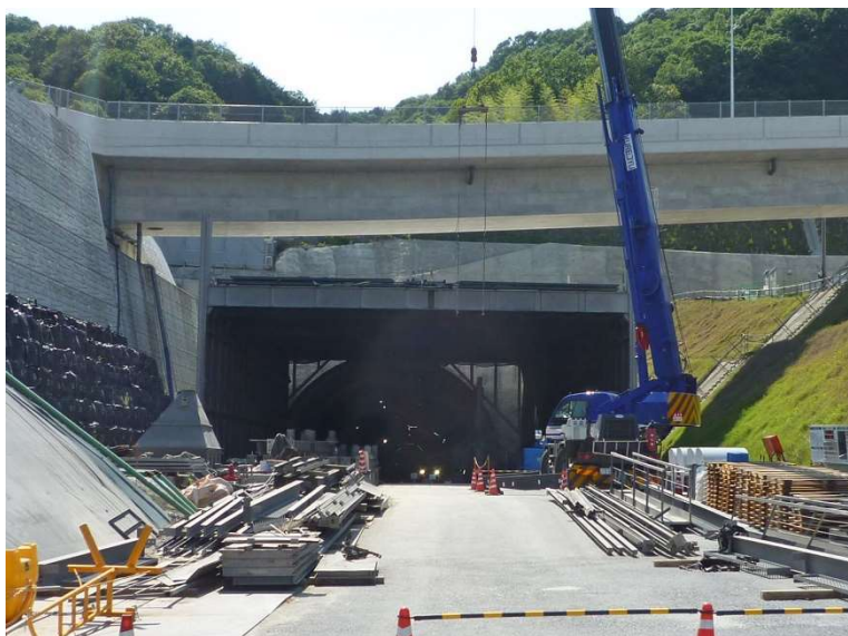
③ 高速 5 号線 NATM トンネル工事
