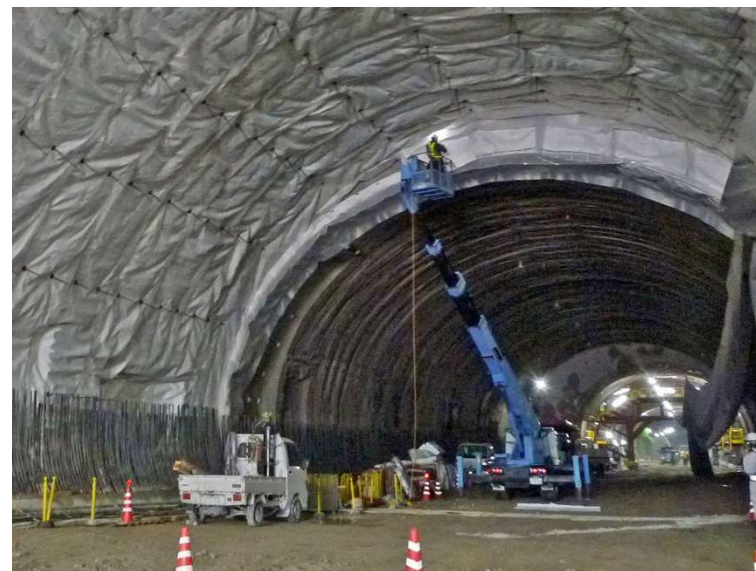
④ 高速 5 号線 NATM トンネル工事
