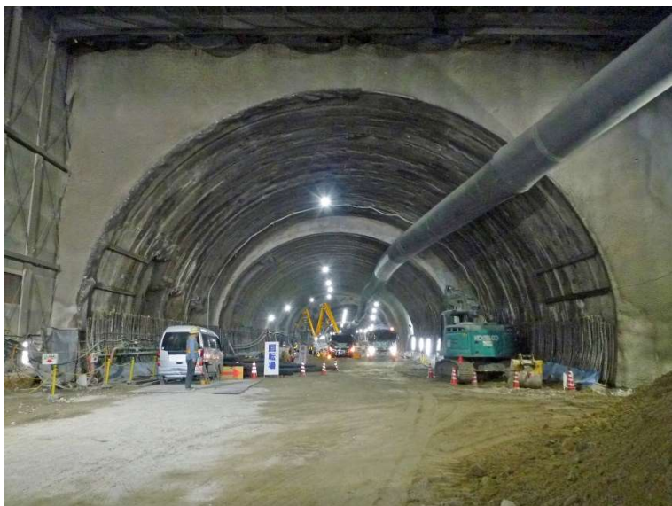
③ 高速 5 号線 NATM トンネル工事
