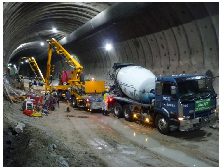
④ 高速5号線 NATM トンネル工事
