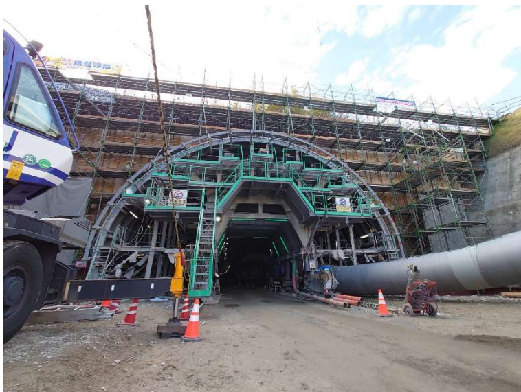
③ 高速 5 号線 NATM トンネル工事
