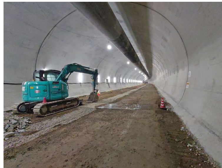
④ 高速 5 号線 NATM トンネル工事
