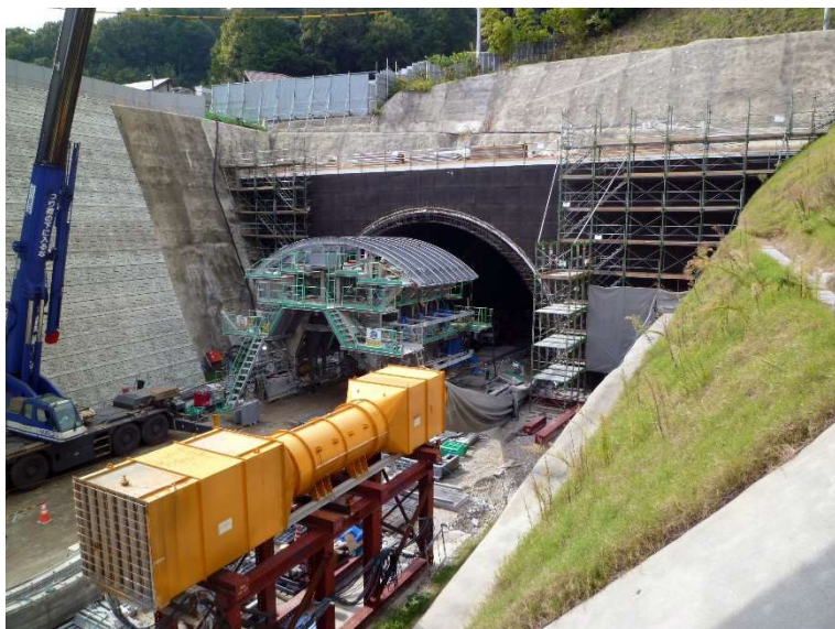
③ 高速 5 号線 NATM トンネル工事
