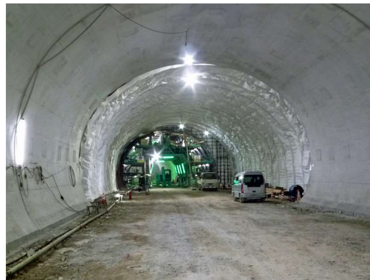
④ 高速 5 号線 NATM トンネル工事
