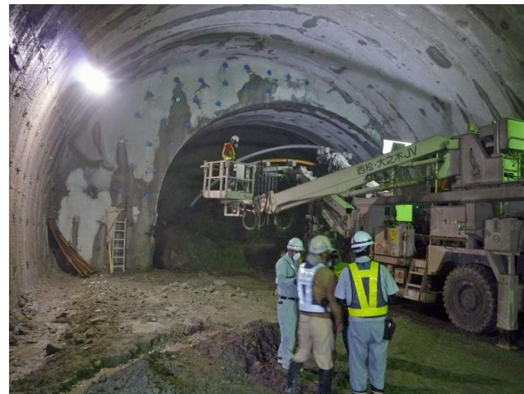
④ 高速5号線 NATM トンネル工事
