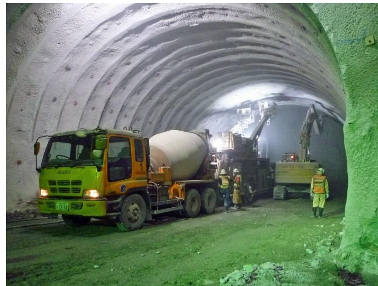
④ 高速5号線 NATM トンネル工事
