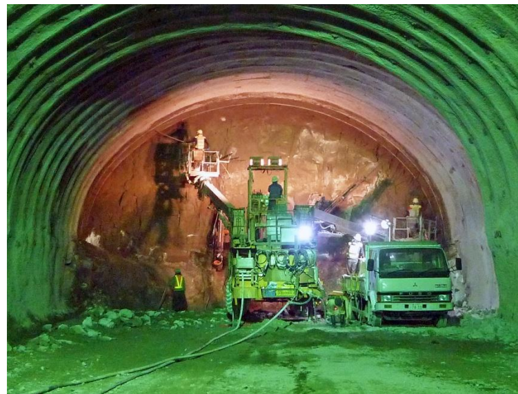
④ 高速5号線 NATM トンネル工事
