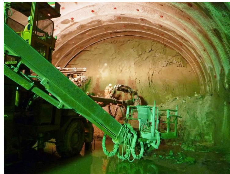
④ 高速5号線 NATM トンネル工事
