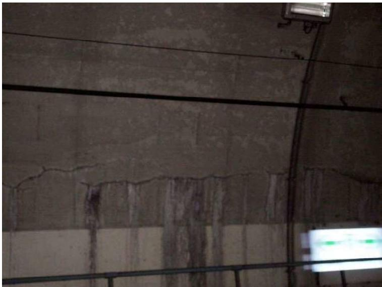
(図3) 福木トンネルのひび割れ
